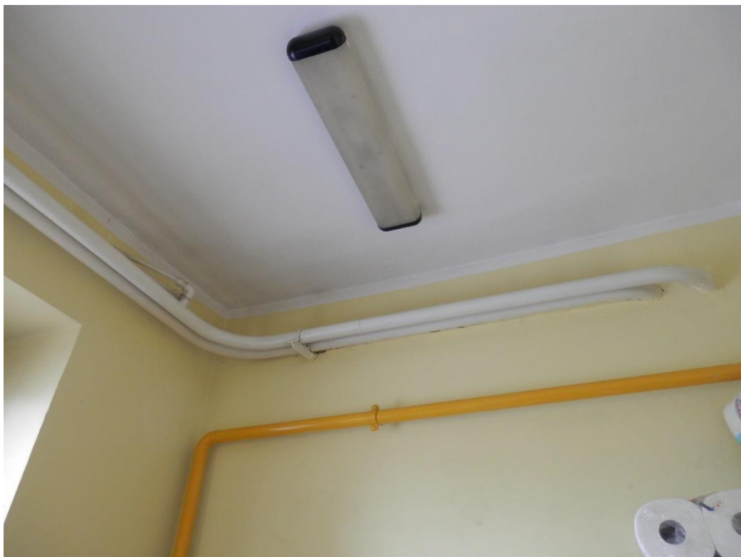
Sposób prowadzenia przewodów z czynnikiem grzewczym - ( bez izolacji termicznej ).
