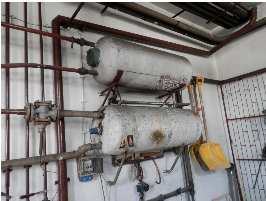
2 podgrzewacze o pojemności 150,0 litrów każdy - górny-wyłączony z eksploatacji w wyniku awarii.
