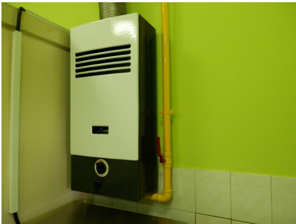
Przepływowy podgrzewacz c.w.u. gazowy - na potrzeby technologiczne kuchni.
