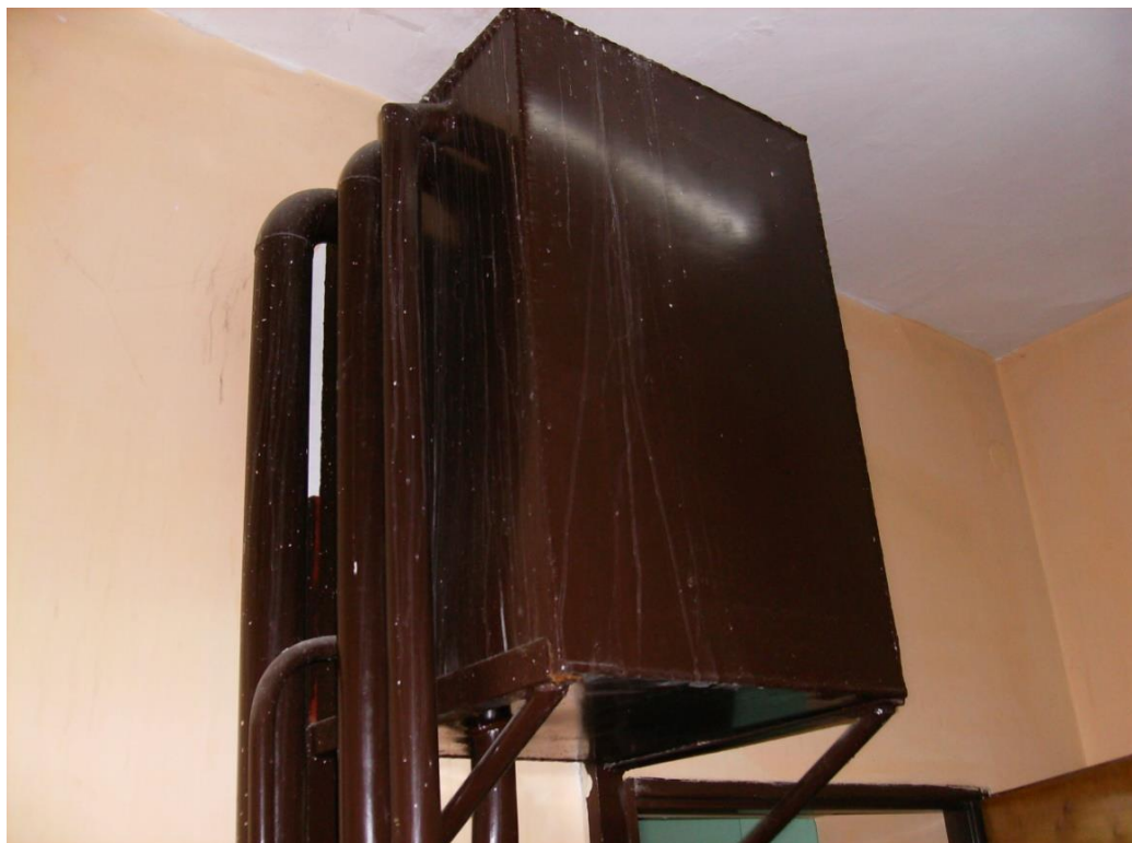
Naczynie wzbiorcze system otwarty, typ B o pojemności 200 dm 3 - pomieszczenie nr 118, zaplecze pracowni informatycznej.
