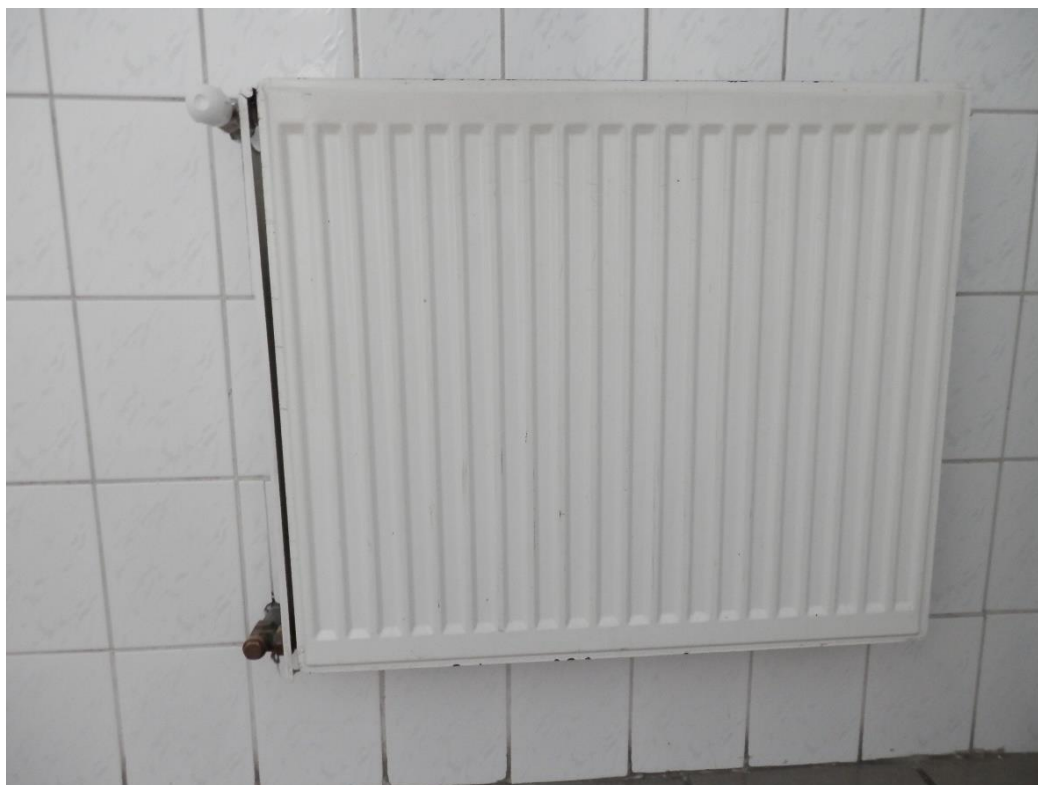
Grzejnik stalowy, płytowy w układzie grzewczym budynku.
