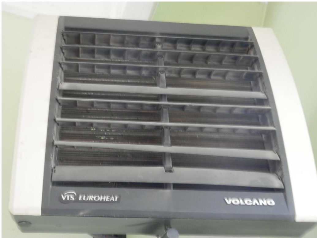
Nagrzewnice wodne typu VOLCANO - ogrzewanie sali sportowej.
