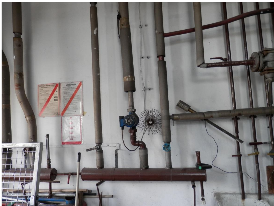
Rozdzielacz czynnika (pompa obiegowa).
