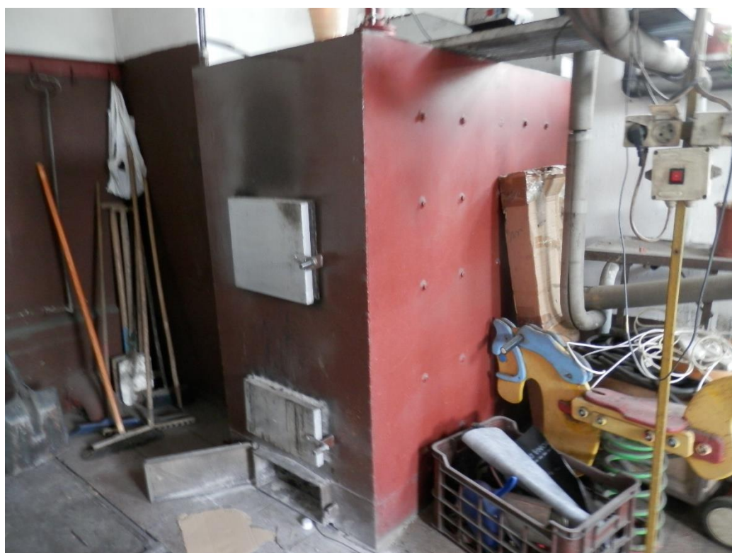
Źródło ciepła - stalowy kocioł grzewczy o mocy 130,0 kW.
