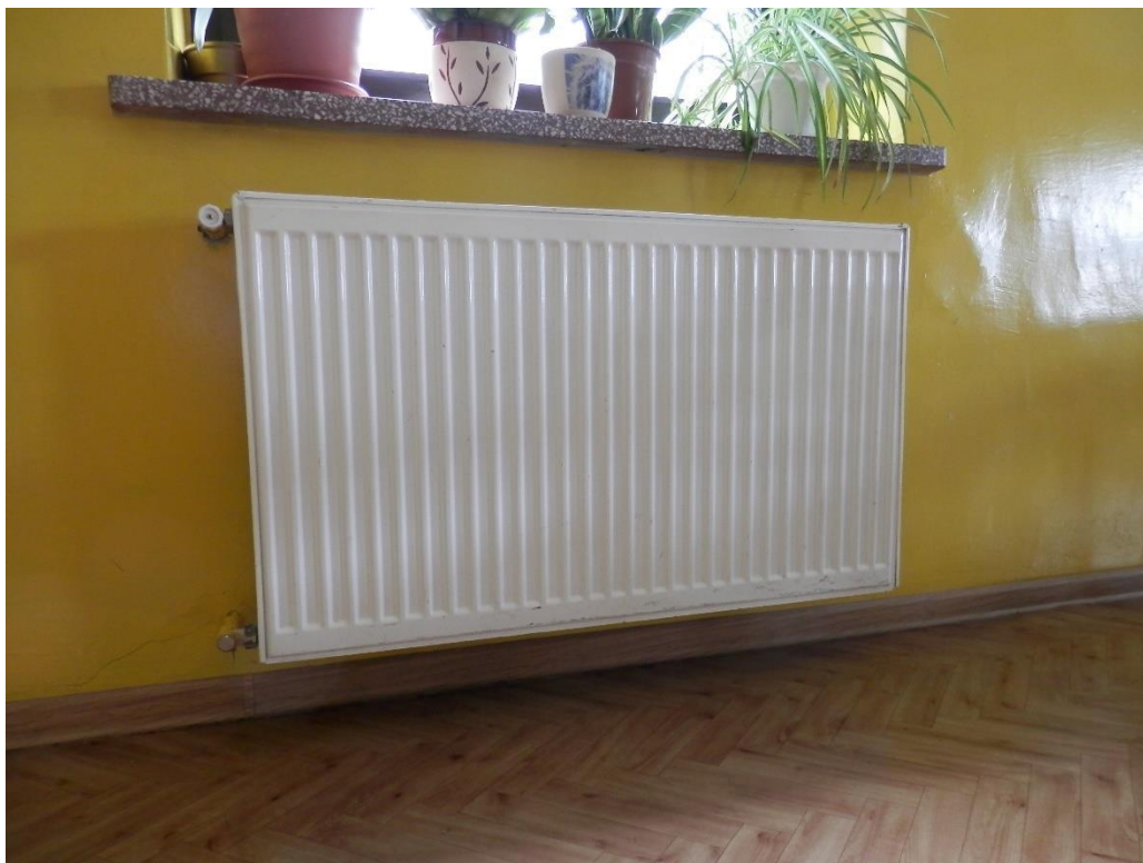
Grzejnik stalowy, płytowy w układzie grzewczym budynku.
